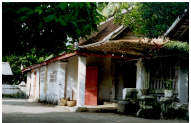
ປະເພດ Type: ວັດ Vat: ສີລິມຸງຄຸນ Siri Moug Khoun ວັດສະດຸກໍ່ສ້າງ Matériaux de construction: BCT ນ້ຳເບີບັນຊີອະນຸລັກ No inventaire: 467
