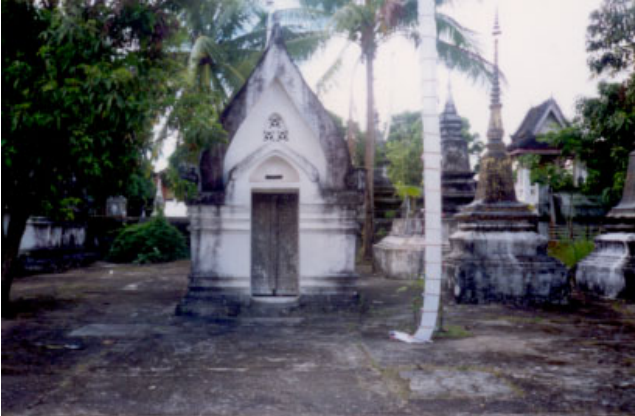
ປະເພດ Type: ວັດ Vat ຊຽງມ່ວນ Xieng Mouane BC ວັດສະດຸກໍ່ສ້າງ Matériaux de construction ນ້ຳເບີບັນຊີອະນຸລັກ No inventaire 493
