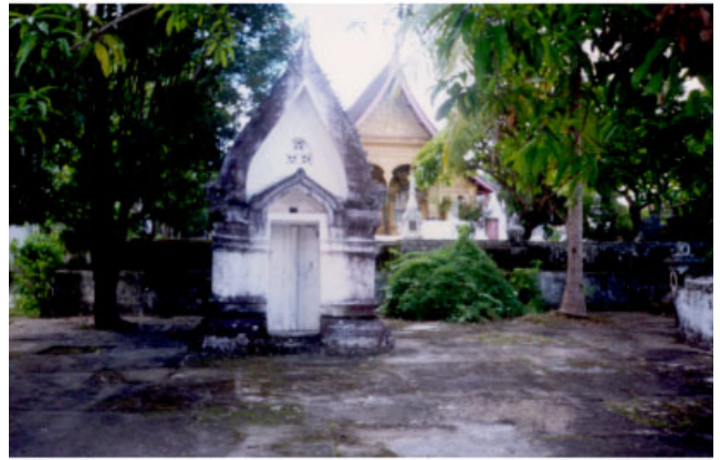
ປະເພດ Type: ວັດ Vat ຊຽງມ່ວນ Xieng Mouane BC ວັດສະດຸກໍ່ສ້າງ Matériaux de construction ນ້ຳເບີບັນຊີອະນຸລັກ No inventaire 494
