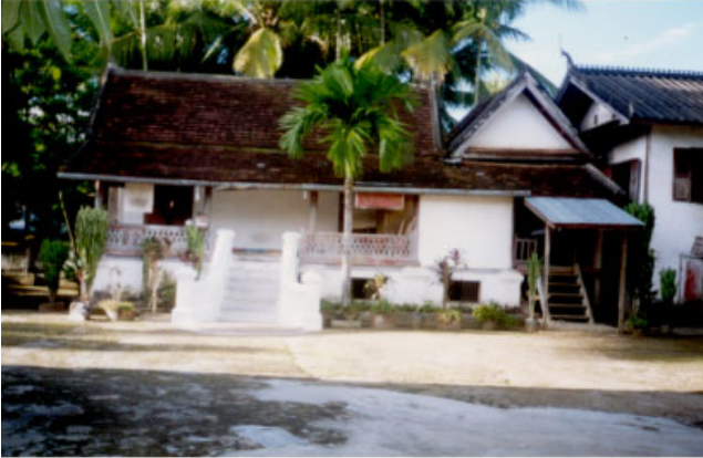
ປະເພດ Type: ວັດ Vat: ສິບຸນເຮືອງ Si Boun Heuang ວັດສະດຸກໍ່ສ້າງ Matériaux de construction: BCT ນ້ຳເບີບັນຊີອະນຸລັກ No inventaire: 462
