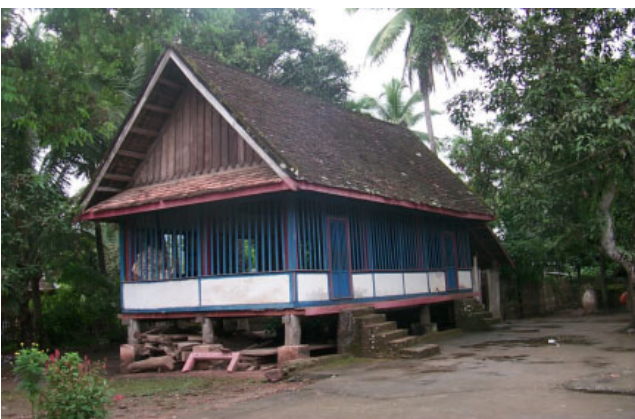
ປະເພດ Type ວັດ Vat ສັງຄະໂລກ Sangkhalock ວັດສະດຸກໍ່ສ້າງ Matériaux de construction BT ນ້ຳເບີບັນຊີອະນຸລັກ No inventaire 610
