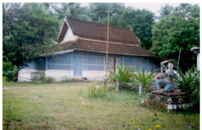
ປະເພດ Type: ວັດ Vat: ທາດຫລວງ That Luang ວັດສະດຸກໍ່ສ້າງ Matériaux de construction: BTBC ນ້ຳເບີບັນຊີອະນຸລັກ No inventaire: 546
