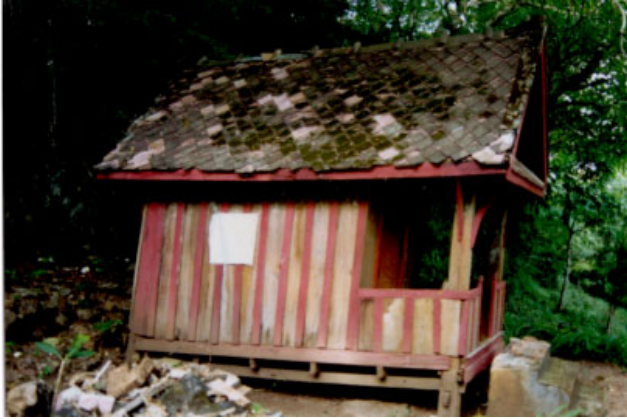
ປະເພດ Type: ວັດ Vat ຖ້ຳຊຽງແມນ Tham Xieng Mene ວັດສະດຸກໍ່ສ້າງ Matériaux de construction: B ນ້ຳເບີບັນຊີອະນຸລັກ No inventaire: 591
