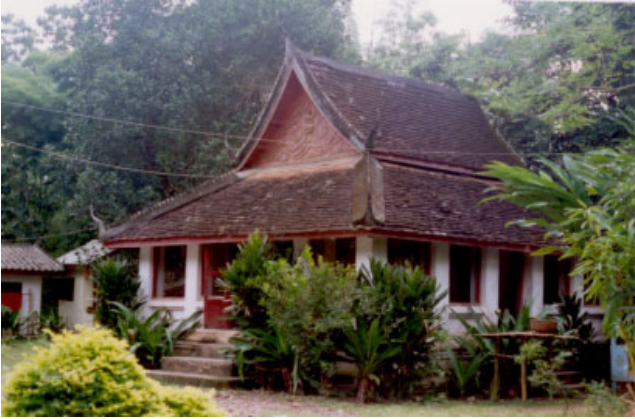
ປະເພດ Type: ວັດ Vat: ເຕົາໂຫ ຕາວໄຫ Tao Hai ວັດສະດຸກໍ່ສ້າງ Matériaux de construction: BC ນ້ຳເບີບັນຊີອະນຸລັກ No inventaire: 567
