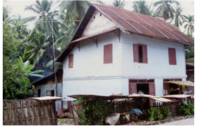
ປະເພດ Typologie ຊື່ບ້ານ Village ໂພນເຮືອງ PHONE HEUANG ເລກທີເຮືອນ No de maison 6/3 ວັດສະດຸກໍ່ສ້າງ Matiériaux de construction BT ນ້ຳເບີບັນຊີອະນຸລັກ No inventaire 104
