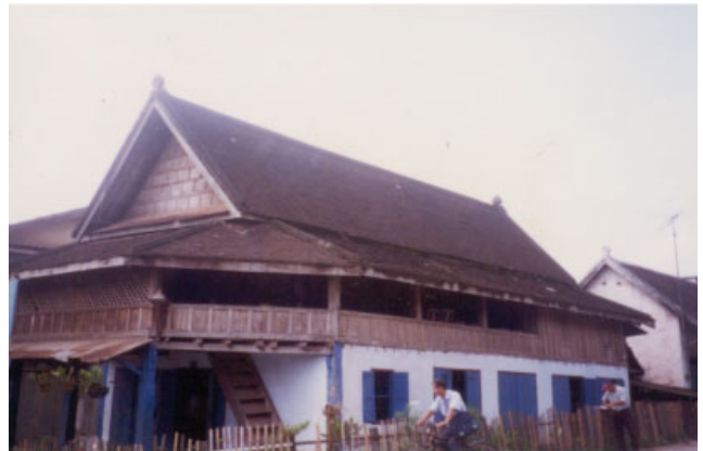
ປະເພດ Typologie ຊື່ບ້ານ Village ເລກທີ່ເຮືອນ No de maison ວັດສະດຸສ້າງ Matiériaux de construction ນ້ຳເບີບັນຊີອະນຸລັກ No inventaire 250 AHAM 54/2 BBC
