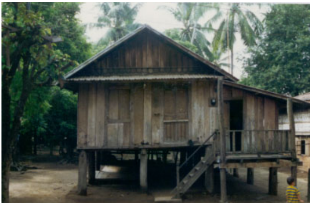
ປະເພດ Typologie ຊື່ບ້ານ Village ຟັນຫຼວງ PHAN LUANG ເລກທີ່ເຮືອນ No de maison 26 ວັດສະດຸກໍ່ສ້າງ Matériaux de construction B ນ້ຳເບີບັນຊີອະນຸລັກ No inventaire 71
