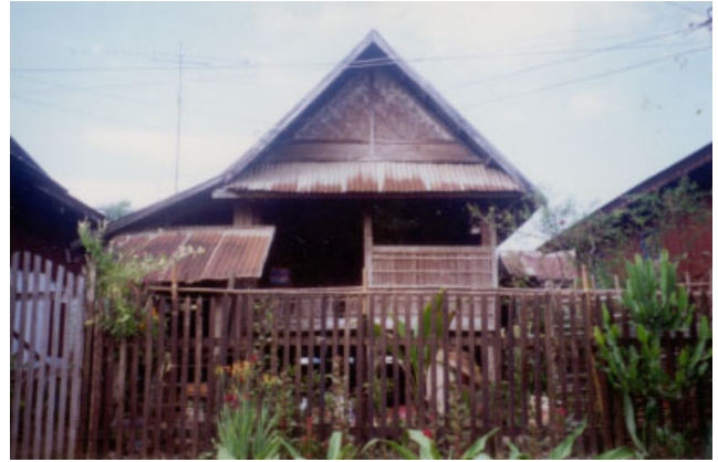
ປະເພດ Typologie ຊື່ບ້ານ Village ຫົວຊຽງ HOUA XIENG ເລກທີເຮືອນ No de maison 37/1 ວັດສະດຸກໍ່ສ້າງ Matiériaux de construction B ນ້ຳເບີບັນຊີອະນຸລັກ No inventaire 38
