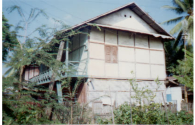
ປະເພດ Typologie ຊື່ບ້ານ Village ໝີ່ນນາ MEUNNA ເລກທີເຮືອນ No de maison 9/5 ວັດສະດຸກໍ່ສ້າງ Materiiaux de construction BT ນ້ຳເບີບັນຊີອະນຸລັກ No inventaire 154
