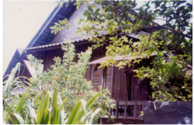
ປະເພດ Typologie ຊື່ບ້ານ Village ເລກທີ່ເຮືອນ No de maison ວັດສະດຸກໍ່ສ້າງ Matiériaux de construction ນ້ຳເບີບັນຊີອະນຸລັກ No inventaire VAT SENE 88/4 B 14
