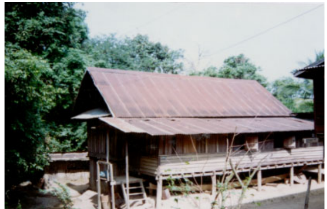
ປະເພດ Typologie ຊື່ບ້ານ Village ຟັນຫຼວງ PHAN LUANG ເລກທີ່ເຮືອນ No de maison 88/10 ວັດສະດຸກໍ່ສ້າງ Matériaux de construction B ນ້ຳເບີບັນຊີອະນຸລັກ No inventaire 72
