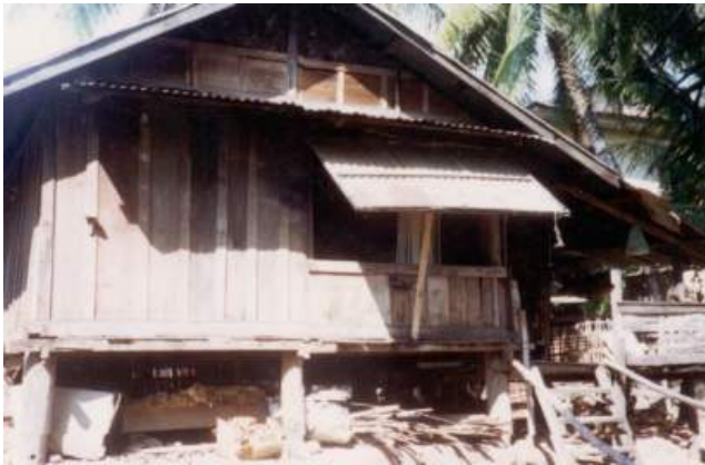
ປະເພດ Typologie ຊື່ບ້ານ Village ເລກທີ່ເຮືອນ No de maison ວັດສະດຸກໍ່ສ້າງ Matiériaux de construction ນ້ຳເບີບັນຊີອະນຸລັກ No inventaire ວັດແສນ VAT SENE 15/4 B 3
