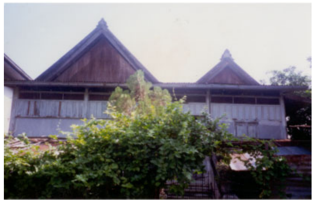
ປະເພດ Typologie ຊື່ບ້ານ Village ວັດທາດ VAT THAT ເລກທີເຮືອນ No de maison 19/2 ວັດສະດຸສ້າງ Matiériaux de construction BTBC ນ້ຳເບີບັນຊີອະນຸລັກ No inventaire 180
