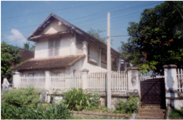
ປະເພດ Typologie ຊື່ບ້ານ Village ວັດໜອງ VAT NONG ເລກທີ່ເຮືອນ No de maison 38/5 ວັດສະດຸກໍ່ສ້າງ Matiériaux de construction BC ນ້ຳເບີບັນຊີອະນຸລັກ No inventaire 303
