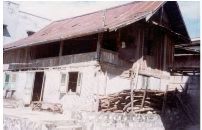
ປະເພດ Typologie ຊື່ບ້ານ Village ເລກທີ່ເຮືອນ No de maison ວັດສະດຸກໍ່ສ້າງ Matiériaux de construction ນ້ຳເບີບັນຊີອະນຸລັກ No inventaire ວັດແສນ VAT SENE 26/4 B 4
