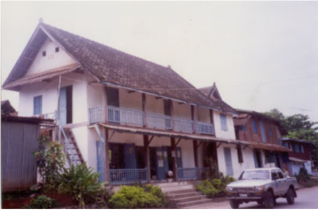
ປະເພດ Typologie ຊື່ບ້ານ Village ປາຂາມ PAKHAM ເລກທີ່ເຮືອນ No de maison 57/8 ວັດສະດຸສ້າງ Matiériaux de construction BT ນ້ຳເບີບັນຊີອະນຸລັກ No inventaire 133
