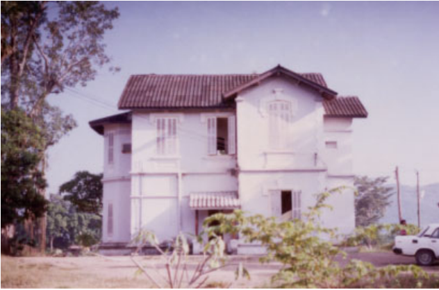
ປະເພດ Typologie ຊື່ບ້ານ Village THAT LUANG ເລກທີ່ເຮືອນ No de maison - ວັດສະດຸສ້າງ Matiériaux de construction BC ນ້ຳເບີບັນຊີອະນຸລັກ No inventaire 349
