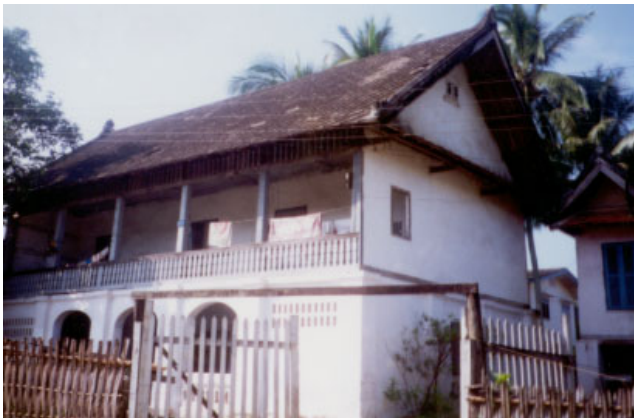
ປະເພດ Typologie ຊື່ບ້ານ Village ວັດທາດ VAT THAT ເລກທີເຮືອນ No de maison 24/2 ວັດສະດຸກໍ່ສ້າງ Matiériaux de construction BCT ບໍ່ມີບັນຊີອະນຸລັກ No inventaire 419
