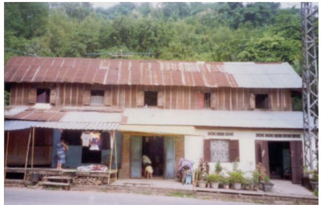
ປະເພດ Typologie ຊື່ບ້ານ Village ອາໄຟ APHAY ເລກທີເຮືອນ No de maison 8-11/3 ວັດສະດຸສ້າງ Matiériaux de construction BTBC ນ້ຳເບີບັນຊີອະນຸລັກ No inventaire 186
