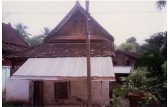
ປະເພດ Typologie ຊື່ບ້ານ Village ອາໄພ APHAY ເລກທີເຮືອນ No de maison 58/3 ວັດສະດຸກໍ່ສ້າງ Matiériaux de construction BBC ນ້ຳເບີບັນຊີອະນຸລັກ No inventaire 258
