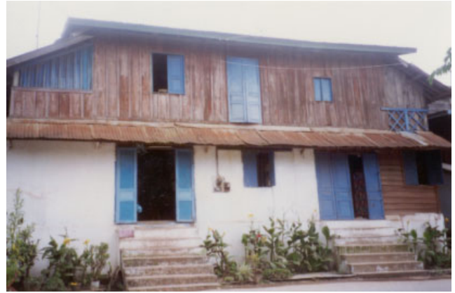
ປະເພດ Typologie ຊື່ບ້ານ Village ປາຂາມ PAKHAM ເລກທີ່ເຮືອນ No de maison 55/8 ວັດສະດຸສ້າງ Matiériaux de construction BT ນ້ຳເບີບັນຊີອະນຸລັກ No inventaire 134
