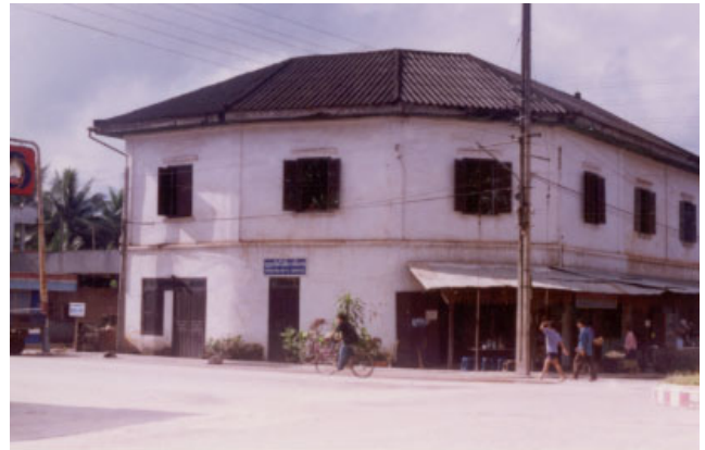
ປະເພດ Typologie ຊື່ບ້ານ Village ວຽງແກ້ວ VIENG KEO ເລກທີ່ເຮືອນ No de maison 81-85/3 ວັດສະດຸກໍ່ສ້າງ Matiériaux de construction BC ກຳເນີດບັນຊີອະນຸລັກ No inventaire 364
