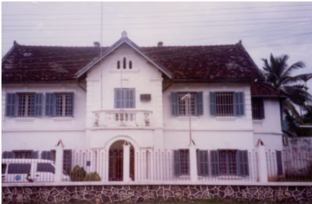
ປະເພດ Typologie ຊື່ບ້ານ Village ປາຂາມ PAKHAM ເລກທີ່ເຮືອນ No de maison - ວັດສະດຸກໍ່ສ້າງ Matiériaux de construction BC ນໍ້າເບີກໍ່ສ້າງອະນຸລັກ No inventaire 327
