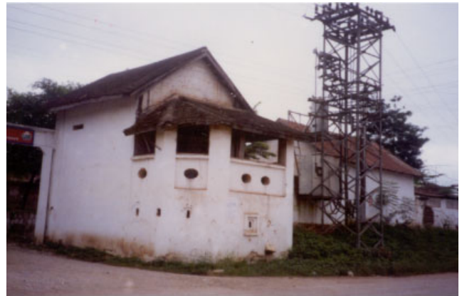
ປະເພດ Typologie ຊື່ບ້ານ Village ເລກທີ່ເຮືອນ No de maison ວັດສະດຸກໍ່ສ້າງ Matiériaux de construction ນ້ຳເບີບັນຊີອະນຸລັກ No inventaire THAT BOSOT - BC 382
