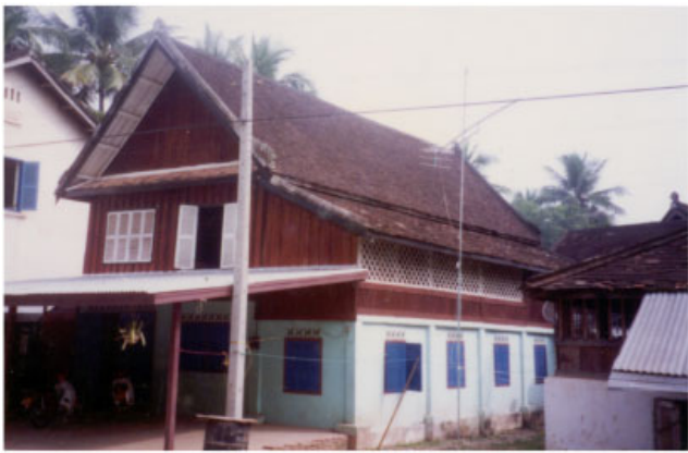
ປະເພດ Typologie ຊື່ບ້ານ Village ອາໄພ APHAY ເລກທີເຮືອນ No de maison 57/3 ວັດສະດຸກໍ່ສ້າງ Matiériaux de construction BBC ນ້ຳເບີບັນຊີອະນຸລັກ No inventaire 257
