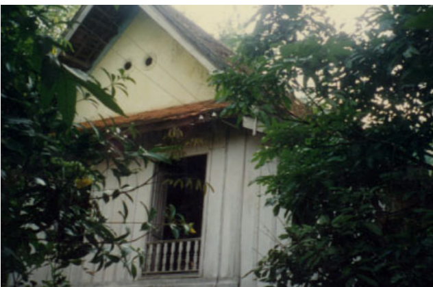
ປະເພດ Typologie ຊຸ້ງບ້ານ Village ເລກທີ່ເຮືອນ No de maison ວັດສະດຸກໍ່ສ້າງ Matiériaux de construction ນ້ຳເບີບັນຊີອະນຸລັກ No inventaire 221 ຈຸນຄ້ອງ CHOUM KHONG 18/7 BBC
