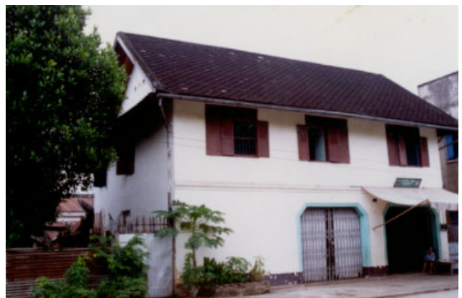
ປະເພດ Typologie ວັດແສນ VAT SENE ຊື່ບ້ານ Village ເລກທີ່ເຮືອນ No de maison 22/4 ວັດສະດຸກໍ່ສ້າງ Matiériaux de construction BCT ນ້ຳເບີກໍ່ສ້າງອະນຸລັກ No inventaire 396
