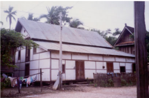
ປະເພດ Typologie ຊື່ບ້ານ Village ປາຂາມ PAKHAM ເລກທີເຮືອນ No de maison 37-38/8 ວັດສະດຸກໍ່ສ້າງ Matiériaux de construction BT ນ້ຳເບີບັນຊີອະນຸລັກ No inventaire 131
