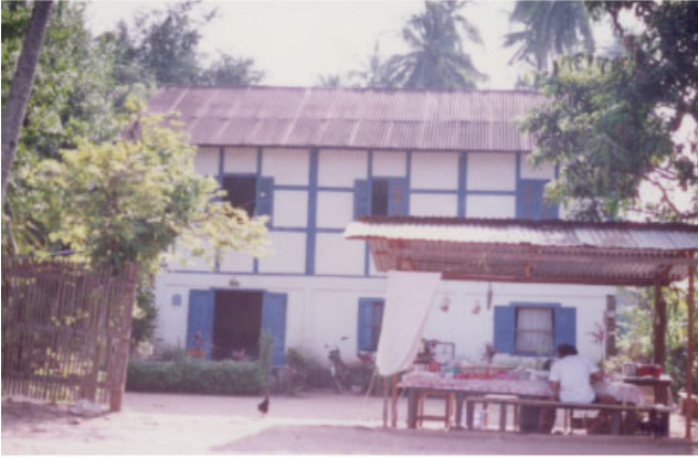
ປະເພດ Typologie ຊື່ບ້ານ Village ເລກທີ່ເຮືອນ No de maison ວັດສະດຸກໍ່ສ້າງ Materiaux de construction ນ້ຳເບີບັນຊີອະນຸລັກ No inventaire THAT LUANG 49 BCT 427
