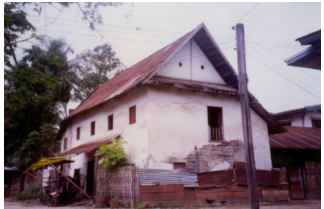
ປະເພດ Typologie ຊື່ບ້ານ Village ປາຂາມ PAKHAM ເລກທີເຮືອນ No de maison 43/8 ວັດສະດຸກໍ່ສ້າງ Matiériaux de construction BT ນ້ຳເບີບັນຊີອະນຸລັກ No inventaire 132
