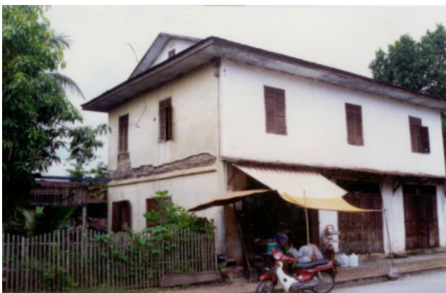
ປະເພດ Typologie ຊື່ບ້ານ Village ວັດແສນ VAT SENE ເລກທີເຮືອນ No de maison 16/4 ວັດສະດຸກໍ່ສ້າງ Matiériaux de construction BT ນ້ຳເບີບັນຊີອະນຸລັກ No inventaire 107
