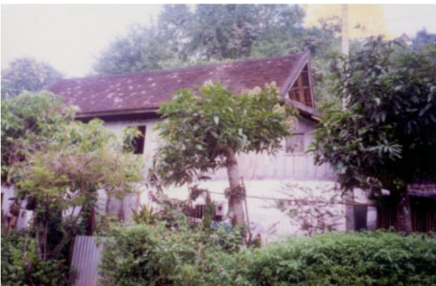
ປະເພດ Typologie ຊື່ບ້ານ Village ອາໄຟ APHAY ເລກທີເຮືອນ No de maison 7/3 ວັດສະດຸສ້າງ Matiériaux de construction BTBC ນ້ຳເບີບັນຊີອະນຸລັກ No inventaire 185
