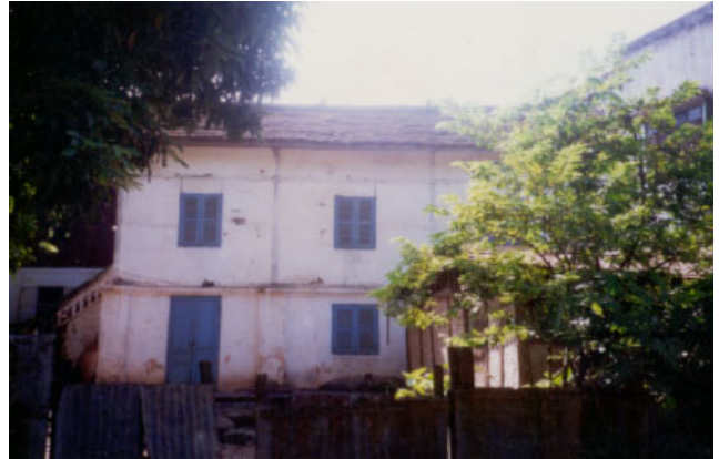
ປະເພດ Typologie ຊື່ບ້ານ Village ວັດທາດ VAT THAT ເລກທີເຮືອນ No de maison 34/2 ວັດສະດຸສ້າງ Matiériaux de construction BTBC ນ້ຳເບີບັນຊີອະນຸລັກ No inventaire 178
