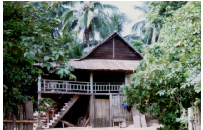
ປະເພດ Typologie ຊື່ບ້ານ Village ຟັນຫຼວງ PHAN LUANG ເລກທີ່ເຮືອນ No de maison 17 ວັດສະດຸກໍ່ສ້າງ Matériaux de construction B ນ້ຳເບີບັນຊີອະນຸລັກ No inventaire 70
