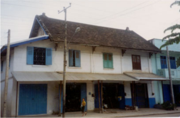
ປະເພດ Typologie ຊື່ບ້ານ Village ວິຂຸນ VIXUN ເລກທີ່ເຮືອນ No de maison 32-34/4 ວັດສະດຸສ້າງ Materiaux de construction BC ນ້ຳເບີບັນຊີອະນຸລັກ No inventaire 385
