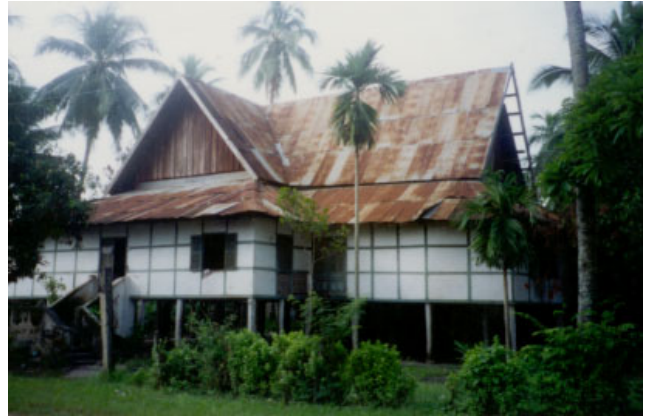
ປະເພດ Typologie ຊື່ບ້ານ Village ປາຂາມ PAKHAM ເລກທີເຮືອນ No de maison 130/8 ວັດສະດຸກໍ່ສ້າງ Matiériaux de construction BT ນ້ຳເບີບັນຊີອະນຸລັກ No inventaire 128
