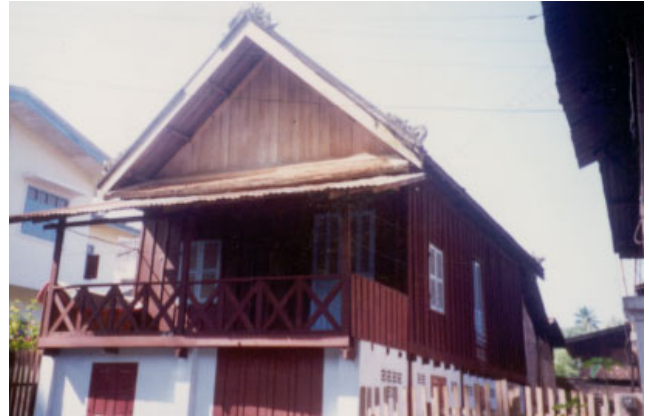
ປະເພດ Typologie ຊຸ້ຍ້ານ Village ວັດທາດ VAT THAT ເລກທີເຮືອນ No de maison 46/2 ວັດສະດຸກໍ່ສ້າງ Matiériaux de construction BBC ນ້ຳເບີບັນຊີອະນຸລັກ No inventaire 242
