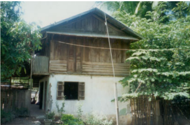
ປະເພດ Typologie ຊື່ບ້ານ Village ໝີ່ນນາ MEUNNA ເລກທີເຮືອນ No de maison 98/5 ວັດສະດຸກໍ່ສ້າງ Materiaux de construction BBC ນ້ຳເບີບັນຊີອະນຸລັກ No inventaire 263
