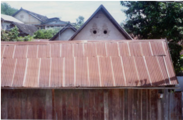
ປະເພດ Typologie ຊື່ບ້ານ Village ວັດແສນ VAT SENE ເລກທີ່ເຮືອນ No de maison 79/4 ວັດສະດຸກໍ່ສ້າງ Matiériaux de construction BT ນ້ຳເບີບັນຊີອະນຸລັກ No inventaire 117
