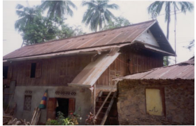
ປະເພດ Typologie ຊື່ບ້ານ Village ອາໄພ APHAY ເລກທີເຮືອນ No de maison 21-22/3 ວັດສະດຸກໍ່ສ້າງ Matiériaux de construction BBC ນ້ຳເບີບັນຊີອະນຸລັກ No inventaire 254
