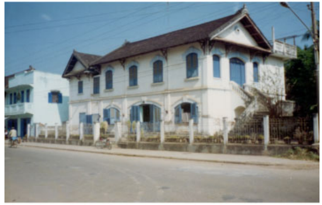
ປະເພດ Typologie ຊື່ບ້ານ Village ວິຂຸນ VIXUN ເລກທີ່ເຮືອນ No de maison 29/4 ວັດສະດຸສ້າງ Materiaux de construction BC ນ້ຳເບີບັນຊີອະນຸລັກ No inventaire 386
