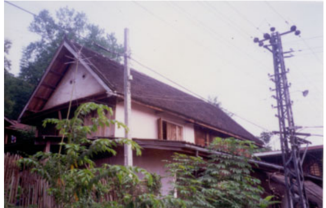
ປະເພດ Typologie ຊື່ບ້ານ Village ອາໄຟ APHAY ເລກທີເຮືອນ No de maison 5/3 ວັດສະດຸສ້າງ Matiériaux de construction BTBC ນ້ຳເບີບັນຊີອະນຸລັກ No inventaire 184
