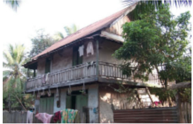
ປະເພດ Typologie ຊຸ້ງບ້ານ Village ເລກທີ່ເຮືອນ No de maison ວັດສະດຸກໍ່ສ້າງ Matiériaux de construction ນ້ຳເບີບັນຊີອະນຸລັກ No inventaire 164
