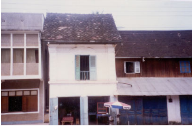
ປະເພດ Typologie ຊື່ບ້ານ Village ຫົວຊຽງ HOUA XIENG ເລກທີເຮືອນ No de maison 21/1 ວັດສະດຸຕໍ່ສ້າງ Matiériaux de construction BBC ນ້ຳເບີບັນຊີອະນຸລັກ No inventaire 235
