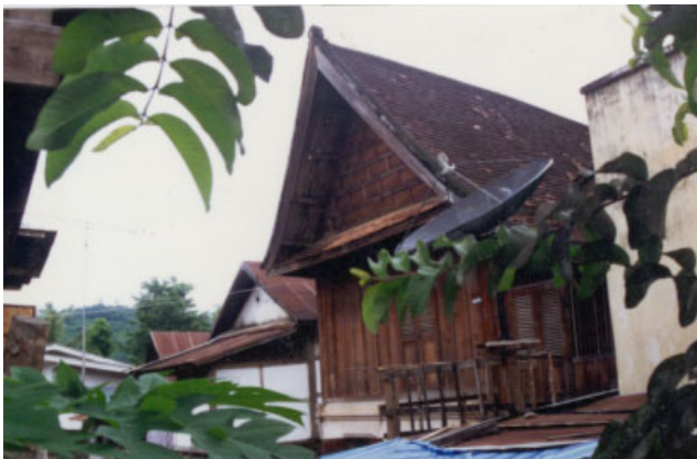
ປະເພດ Typologie ຊຸ້ງບ້ານ Village ເລກທີ່ເຮືອນ No de maison ວັດສະດຸກໍ່ສ້າງ Matiériaux de construction ນ້ຳເບີບັນຊີອະນຸລັກ No inventaire 197
