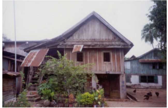
ປະເພດ Typologie ຊື່ບ້ານ Village ວິຂຸນ VIXUN ເລກທີເຮືອນ No de maison 139/4 ວັດສະດຸກໍ່ສ້າງ Matiériaux de construction B ນ້ຳເບີບັນຊີອະນຸລັກ No inventaire 56
