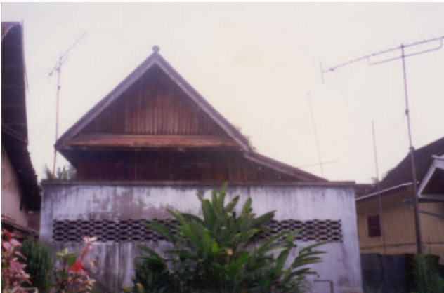
ປະເພດ Typologie ຊື່ບ້ານ Village ອາໄພ APHAY ເລກທີເຮືອນ No de maison 56/3 ວັດສະດຸກໍ່ສ້າງ Matiériaux de construction BBC ນ້ຳເບີບັນຊີອະນຸລັກ No inventaire 255
