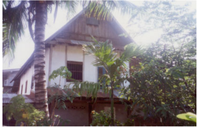
ປະເພດ Typologie ຊື່ບ້ານ Village ວັດທາດ VAT THAT ເລກທີເຮືອນ No de maison 14/2 ວັດສະດຸກໍ່ສ້າງ Matiériaux de construction BCT ບໍ່ມີບັນຊີອະນຸລັກ No inventaire 416
