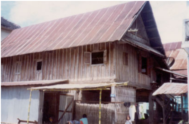
ປະເພດ Typologie ຊື່ບ້ານ Village ເລກທີ່ເຮືອນ No de maison ວັດສະດຸກໍ່ສ້າງ Matiériaux de construction ນ້ຳເບີບັນຊີອະນຸລັກ No inventaire VAT SENE 85/4 B 15
