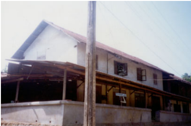
ປະເພດ Typologie ຊື່ບ້ານ Village ວັດທາດ VAT THAT ເລກທີເຮືອນ No de maison 37/2 ວັດສະດຸກໍ່ສ້າງ Matiériaux de construction BCT ບໍ່ມີບັນຊີອະນຸລັກ No inventaire 417
