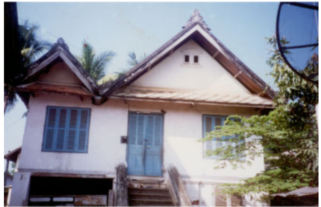
ປະເພດ Typologie ຊື່ບ້ານ Village ວັດທາດ VAT THAT ເລກທີເຮືອນ No de maison 25/2 ວັດສະດຸກໍ່ສ້າງ Matiériaux de construction BCT ບໍ່ມີບັນຊີອະນຸລັກ No inventaire 418
