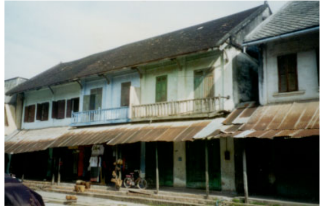
ປະເພດ Typologie ຊຸ້ງຍານ Village ເລກທີເຮືອນ No de maison ວັດສະດຸກໍ່ສ້າງ Matiériaux de construction ນ້ຳເບີບັນຊີອະນຸລັກ No inventaire ຊຽງມ່ວນ XIENG MOUANE 5-8/6 BCT 410
