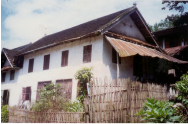
ປະເພດ Typologie ຊື່ບ້ານ Village ວັດແສນ VAT SENE ເລກທີ່ເຮືອນ No de maison 71/4 ວັດສະດຸກໍ່ສ້າງ Matiériaux de construction BT ນ້ຳເບີບັນຊີອະນຸລັກ No inventaire 115
