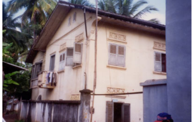
ປະເພດ Typologie ຊຸ້ງຍາມ Village ເລກທີ່ເຮືອນ No de maison ວັດສະດຸກໍ່ສ້າງ Matiériaux de construction ນ້ຳເບີບັນຊີອະນຸລັກ No inventaire 320 ຈຸມຄ້ອງ CHOUM KHONG - BC
