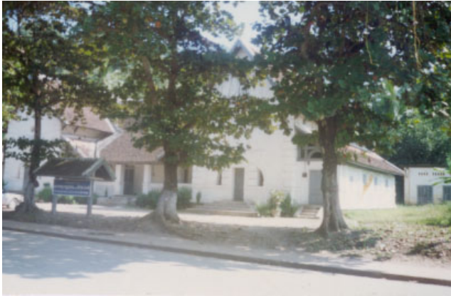
ປະເພດ Typologie ຊື່ບ້ານ Village ປາຂາມ PAKHAM ເລກທີ່ເຮືອນ No de maison - ວັດສະດຸກໍ່ສ້າງ Matiériaux de construction BC ນໍ້າເບີກໍ່ສ້າງອະນຸລັກ No inventaire 325
