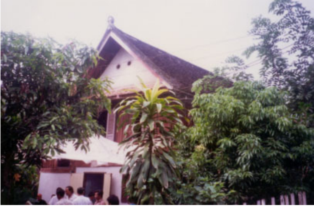
ປະເພດ Typologie ຊື່ບ້ານ Village ອາໄພ APHAY ເລກທີເຮືອນ No de maison 76/3 ວັດສະດຸກໍ່ສ້າງ Materiaux de construction BBC ນ້ຳເບີບັນຊີອະນຸລັກ No inventaire 259
