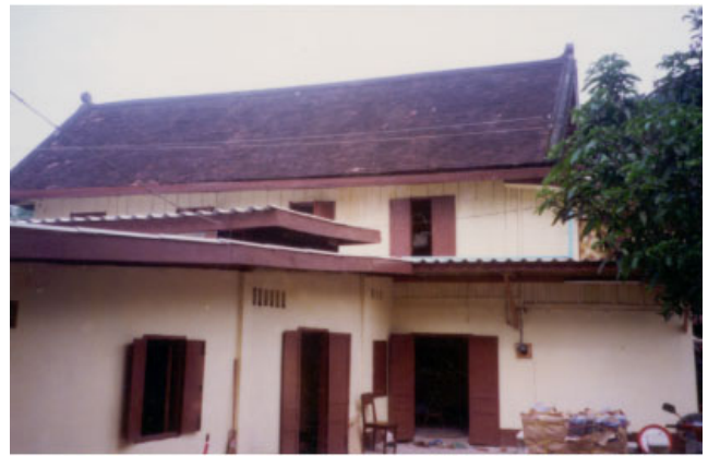
ປະເພດ Typologie ຊື່ບ້ານ Village ອາໄພ APHAY ເລກທີເຮືອນ No de maison 53/3 ວັດສະດຸກໍ່ສ້າງ Matiériaux de construction BBC ນ້ຳເບີບັນຊີອະນຸລັກ No inventaire 256
