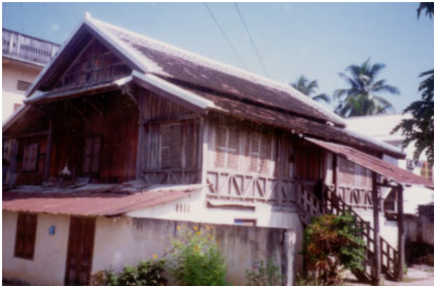
ປະເພດ Typologie ຊຸ້ຍ້ານ Village ວັດທາດ VAT THAT ເລກທີເຮືອນ No de maison 50/2 ວັດສະດຸກໍ່ສ້າງ Matiériaux de construction BBC ນ້ຳເບີບັນຊີອະນຸລັກ No inventaire 243
