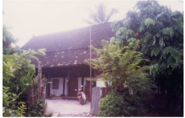
ປະເພດ Typologie ຊື່ບ້ານ Village ອາໄພ APHAY ເລກທີເຮືອນ No de maison 67/3 ວັດສະດຸກໍ່ສ້າງ Materiaux de construction BBC ນ້ຳເບີບັນຊີອະນຸລັກ No inventaire 260
