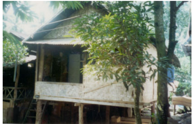
ປະເພດ Typologie ຊຸ້ງຍາມ Village ເລກທີ່ເຮືອນ No de maison ວັດສະດຸກໍ່ສ້າງ Matiériaux de construction ນ້ຳເບີບັນຊີອະນຸລັກ No inventaire ຈຸນຄໍ້ອງ CHOUM KHONG 24/7 B 22
