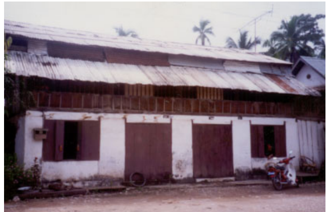
ປະເພດ Typologie ຊື່ບ້ານ Village ປາຂາມ PAKHAM ເລກທີເຮືອນ No de maison 34/8 ວັດສະດຸກໍ່ສ້າງ Matiériaux de construction BT ນ້ຳເບີບັນຊີອະນຸລັກ No inventaire 130
