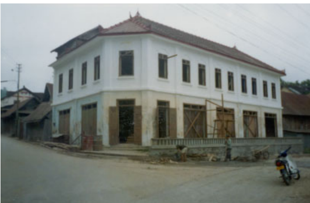
ປະເພດ Typologie ຊຸ້ງຍາມ Village ເລກທີ່ເຮືອນ No de maison ວັດສະດຸກໍ່ສ້າງ Matiériaux de construction ນ້ຳເບີບັນຊີອະນຸລັກ No inventaire 323 ວັດແສນ VAT SENE - BC
