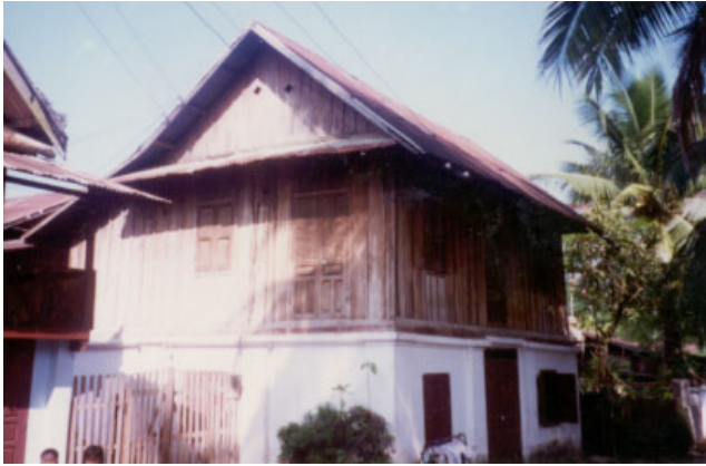
ປະເພດ Typologie ຊຸ້ຍ້ານ Village ວັດທາດ VAT THAT ເລກທີເຮືອນ No de maison 45/2 ວັດສະດຸກໍ່ສ້າງ Matiériaux de construction BBC ນ້ຳເບີບັນຊີອະນຸລັກ No inventaire 241
