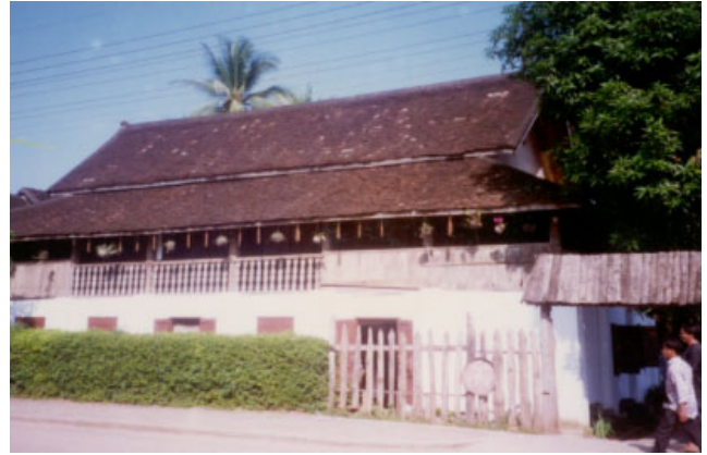
ປະເພດ Typologie ຊື່ບ້ານ Village ວັດທາດ VAT THAT ເລກທີເຮືອນ No de maison 22/2 ວັດສະດຸຕໍ່ສ້າງ Matiériaux de construction BBC ນ້ຳເບີບັນຊີອະນຸລັກ No inventaire 236
