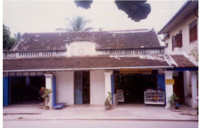
ປະເພດ Typologie ຊື່ບ້ານ Village ປາຂາມ PAKHAM ເລກທີ່ເຮືອນ No de maison 22/8 ວັດສະດຸກໍ່ສ້າງ Matiériaux de construction BC ນໍ້າເບີກໍ່ສ້າງອະນຸລັກ No inventaire 326
