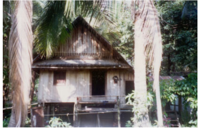
ປະເພດ Typologie ຊຸ້ງຍາມ Village ເລກທີ່ເຮືອນ No de maison ວັດສະດຸກໍ່ສ້າງ Matiériaux de construction ນ້ຳເບີບັນຊີອະນຸລັກ No inventaire ຈຸນຄໍ້ອງ CHOUM KHONG 43/6 B 20
