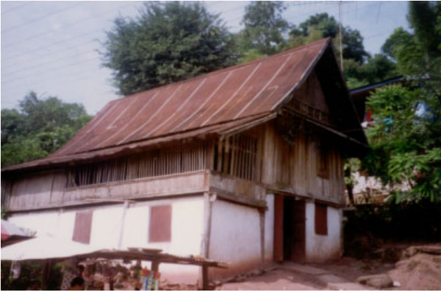
ປະເພດ Typologie ຊື່ບ້ານ Village ອາໄພ APHAY ເລກທີເຮືອນ No de maison 14/3 ວັດສະດຸກໍ່ສ້າງ Matiériaux de construction BBC ນ້ຳເບີບັນຊີອະນຸລັກ No inventaire 253
