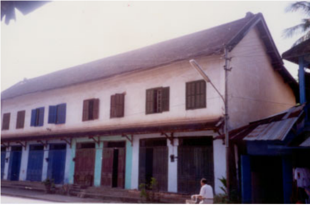
ປະເພດ Typologie ຊຸ້ງຍານ Village ເລກທີເຮືອນ No de maison ວັດສະດຸກໍ່ສ້າງ Matiériaux de construction ນ້ຳເບີບັນຊີອະນຸລັກ No inventaire ຊຽງມ່ວນ XIENG MOUANE 56-59/6 BCT 409
