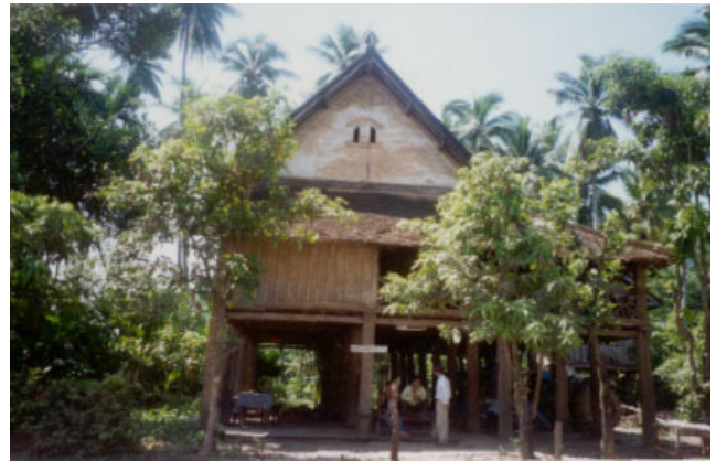
ປະເພດ Typologie ຊື່ບ້ານ Village ໝິ່ນນາ MEUNNA ເລກທີເຮືອນ No de maison 103/5 ວັດສະດຸກໍ່ສ້າງ Matiériaux de construction B ນ້ຳເບີບັນຊີອະນຸລັກ No inventaire 58
