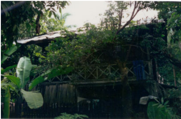
ປະເພດ Typologie ຊື່ບ້ານ Village ຟັນຫຼວງ PHAN LUANG ເລກທີ່ເຮືອນ No de maison 24 ວັດສະດຸກໍ່ສ້າງ Matériaux de construction B ນ້ຳເບີບັນຊີອະນຸລັກ No inventaire 69
