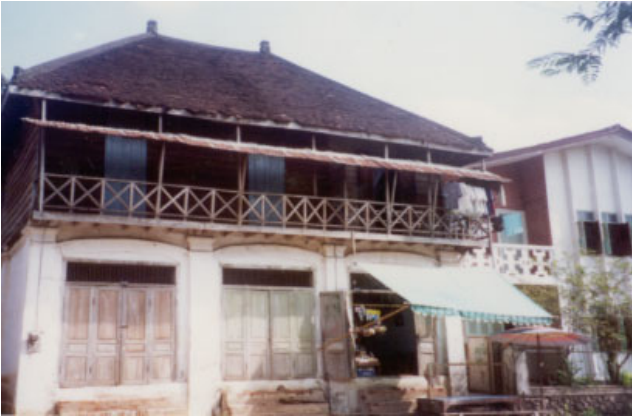
ປະເພດ Typologie ຊຸ້ງບ້ານ Village ເລກທີ່ເຮືອນ No de maison ວັດສະດຸກໍ່ສ້າງ Matiériaux de construction ນ້ຳເບີບັນຊີອະນຸລັກ No inventaire 217 ຈຸນຄ້ອງ CHOUM KHONG 56/7 BBC
