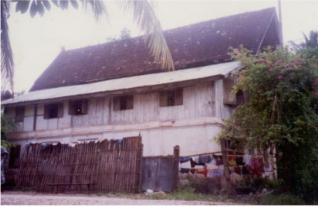
ປະເພດ Typologie ຊື່ບ້ານ Village ປາຂາມ PAKHAM ເລກທີເຮືອນ No de maison 39/8 ວັດສະດຸສ້າງ Matiériaux de construction BTBC ນ້ຳເບີບັນຊີອະນຸລັກ No inventaire 175
